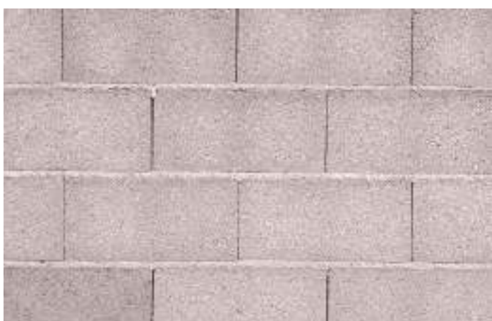
Blocchi in CLS
